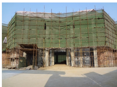
Das Hauptgerüst des Sales Center ist bereits fertig - der Innenausbau beginnt,
